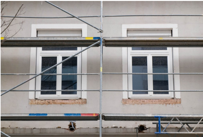
Nacktes Gründerzeithaus: Die Fassaden-Verzierungen wurden im Rahmen einer Sanierung entfernt. Lucas Wahl
